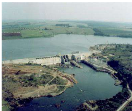
FIGURA 4. Usina Hidrelétrica Piraju
